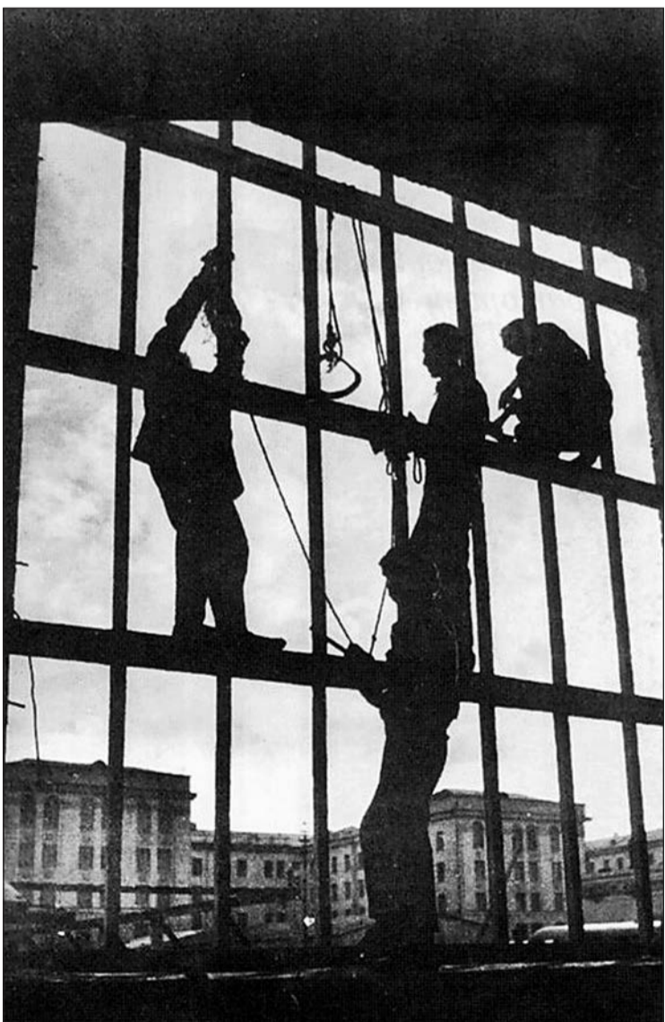
Строительство лабораторного корпуса ИС факультета
