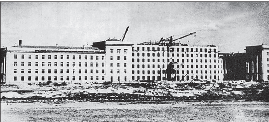
Строительство главного корпуса ЧПИ
