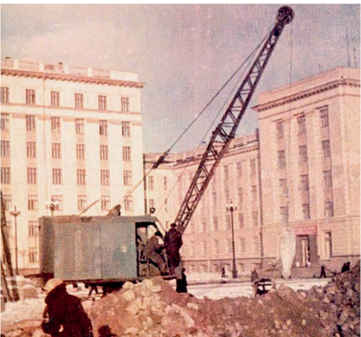
Прокладка коммуникаций возле ЧПИ
