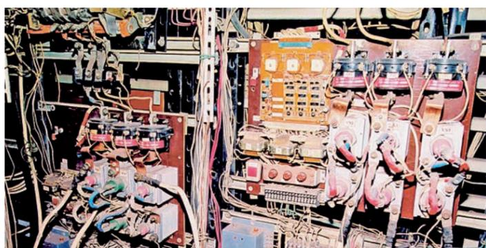
Тиристорные регуляторы напряжения системы управления асинхронными электроприводами насосов гран-бассейна шлакоплавильного цеха ОАО «Челябинский трубопрокатный завод»
